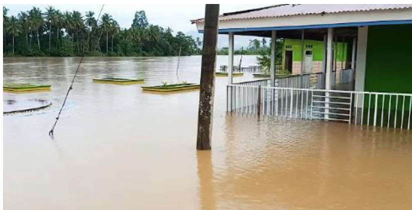
Gambar 1. Kondisi Banjir di Desa Puuwanggudu, Kecamatan Asera, Kabupaten Konawe.
